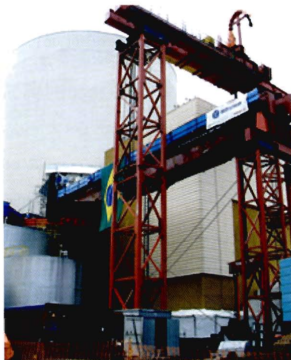
Figura 11. Atividade de troca dos Geradores de Vapor da CNAAA-1
